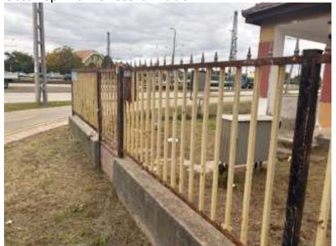
Ingatlan utcafronti kerítése
