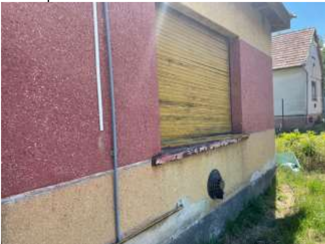
Épület képe az udvarból nézve
