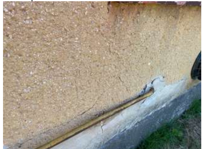
Lábazat máladozik, - szigetelés hiányos
