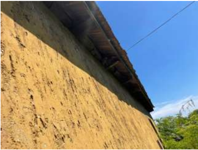
Repesztett homlokzat
