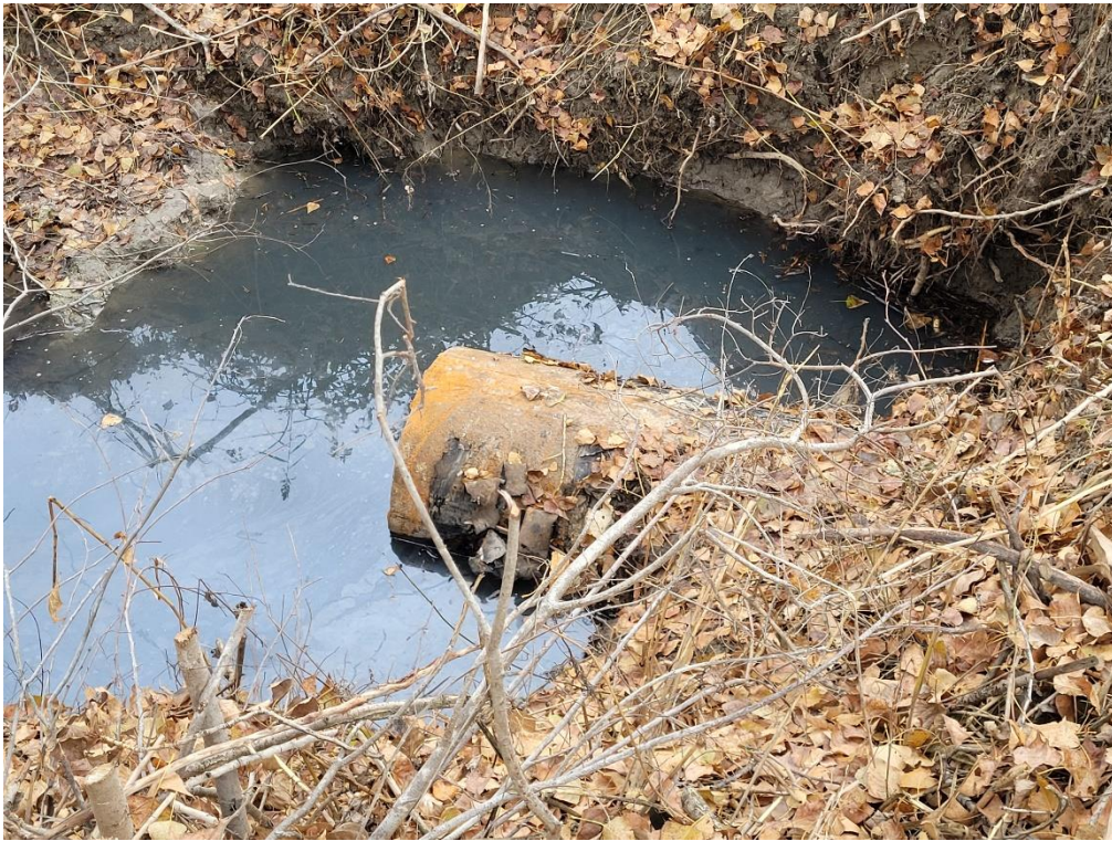
7. kép: A földutat és a vízvezetékeket is keresztező áteresz felvízi oldala - hrsz: 0231
