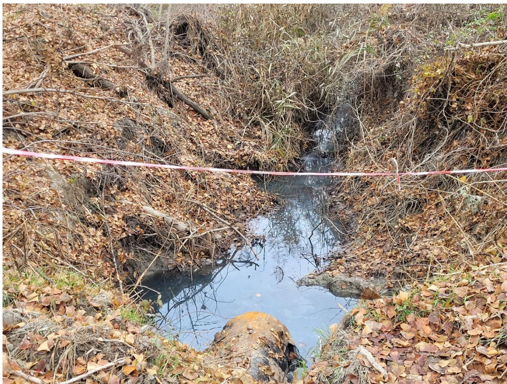
7. kép: A földutat és a vízvezetékeket is keresztező áteresz felvízi oldala - hrsz: 0231
