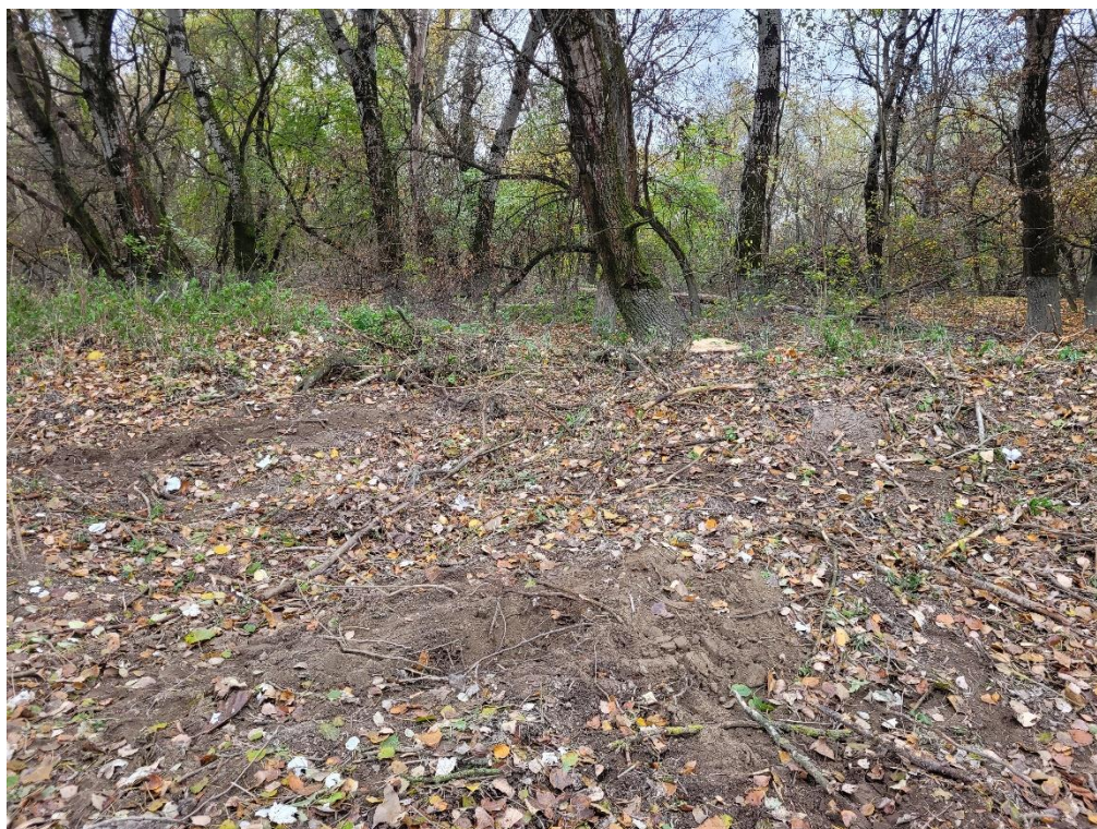
15. kép: Átszakadt árvízvédelmi töltés a Dunai Holtág mellett – hrs: 0251
