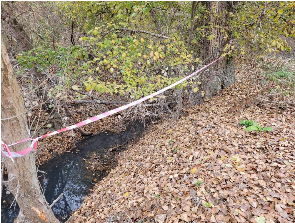
5. kép: Iszapfogó a Zsilip felvízi oldalán - hrsz: 0251
